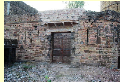
बालाबेहट किले का अनुरक्षण कार्य, पूर्व एवं पश्चात्
